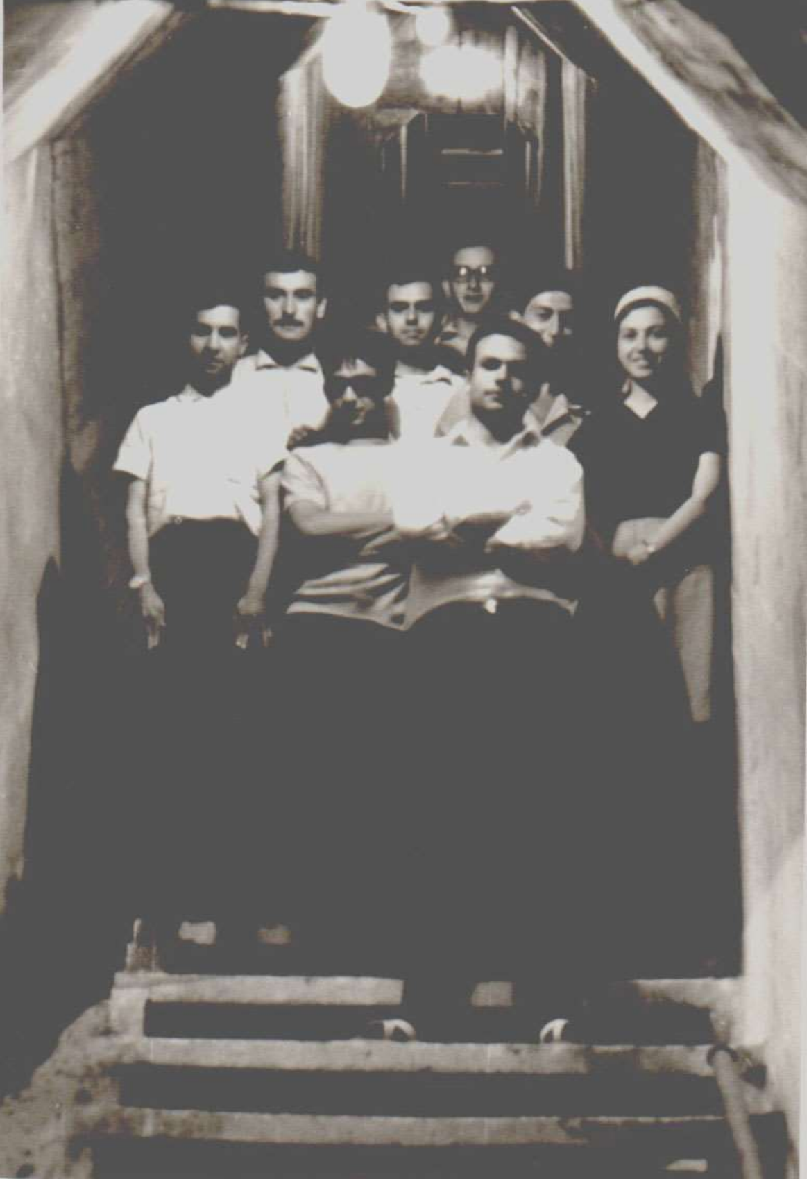
Kemer Barajı Beton Gövdesindeki Galeri
