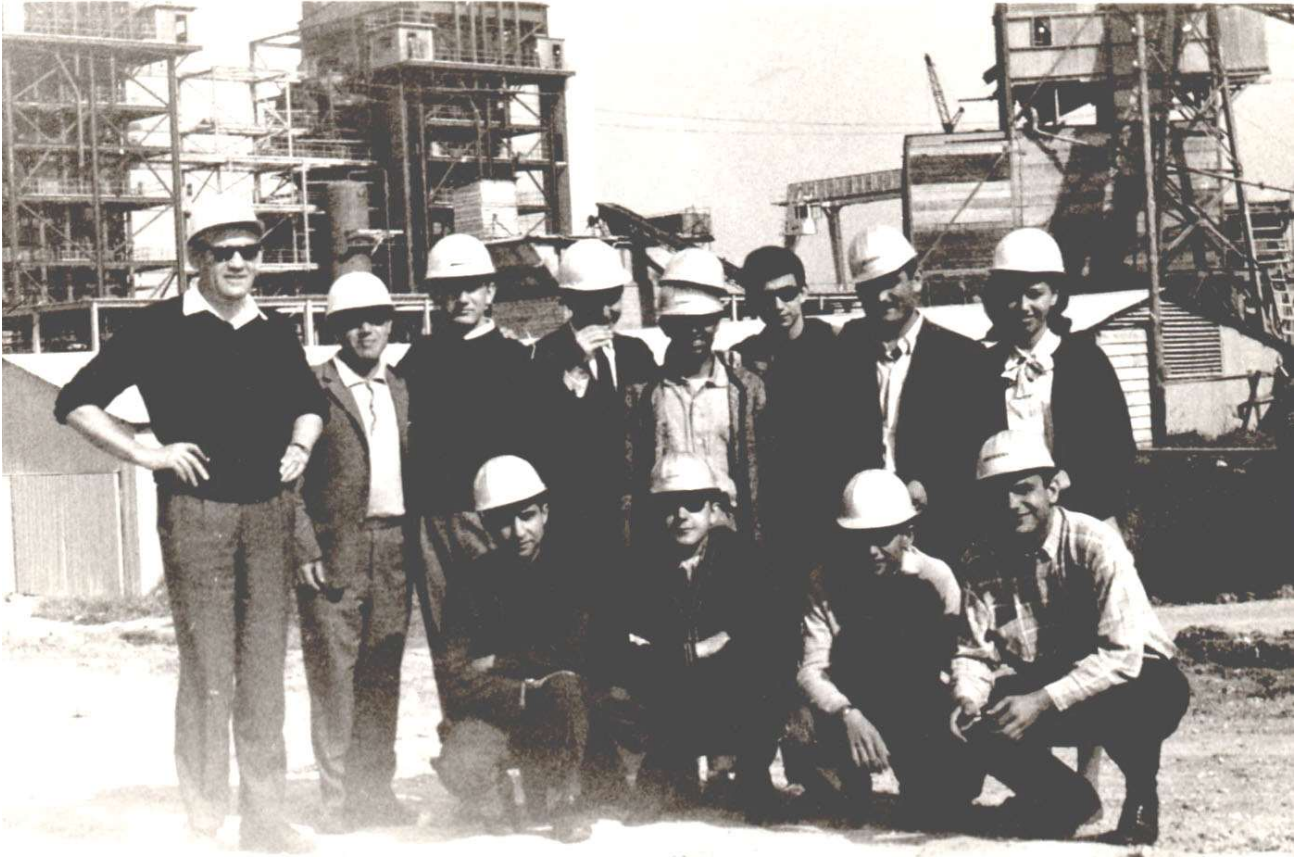
Ambarlı Termik Santralı İnşaatı Şantiyesi
